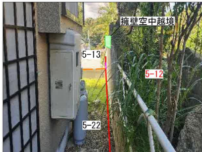
① 土留空中越境 越境幅最大47mm
