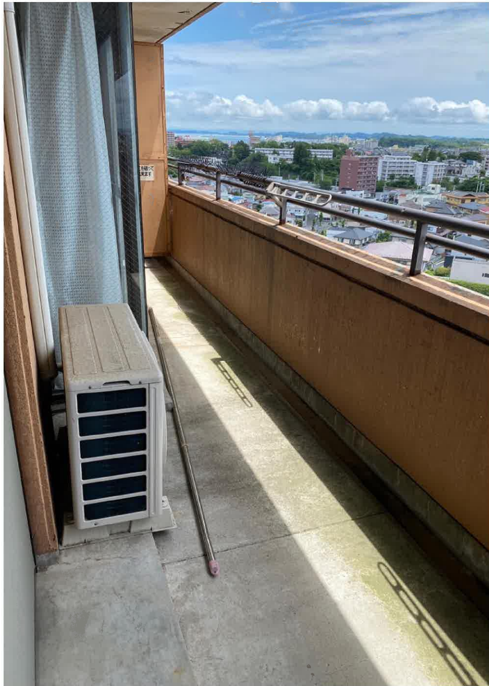
メゾネット1階バルコニー
